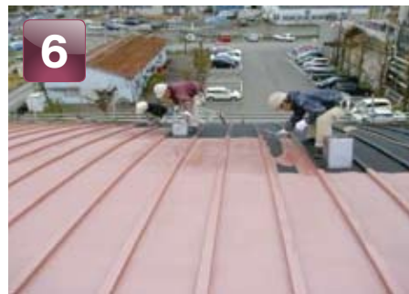
仕上塗料の塗布
