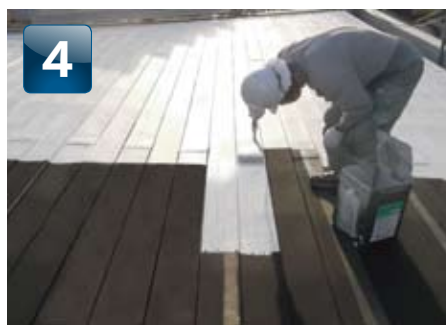
仕上塗料の塗布
