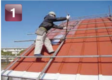
メタルプライマーの塗布(全面塗布)
