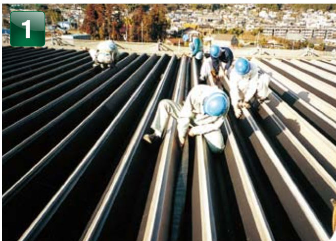
1 メタルプライマー、リブSボンド塗布後 リブシート張り付け(谷部)
