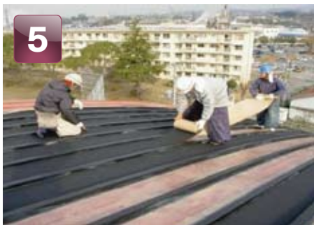
リブシートの張り付け
