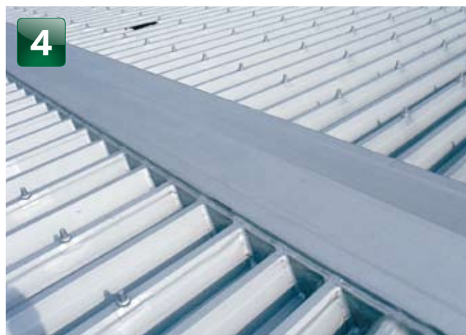
4 仕上塗料の塗布し、完成
