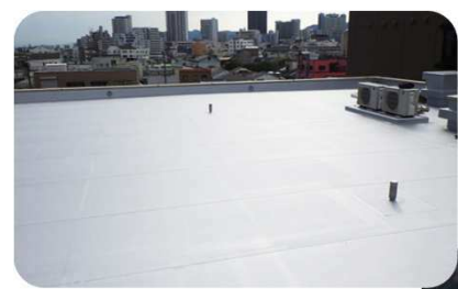
屋上防水 施工例
