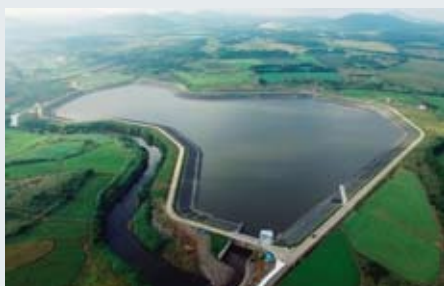
農業用貯水池で使用される“遮水シート”
