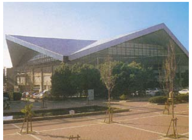
西宮市中央体育館
