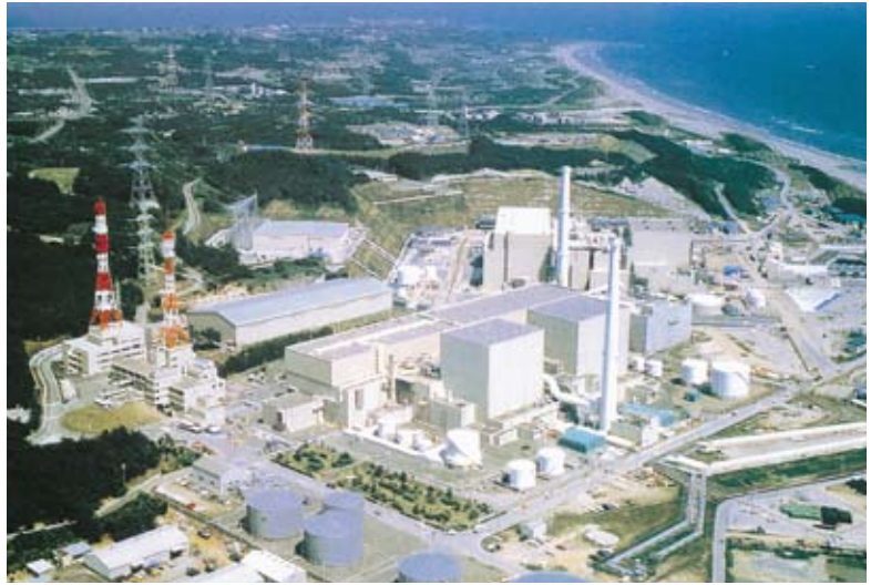
中部電力浜岡原子力発電所
