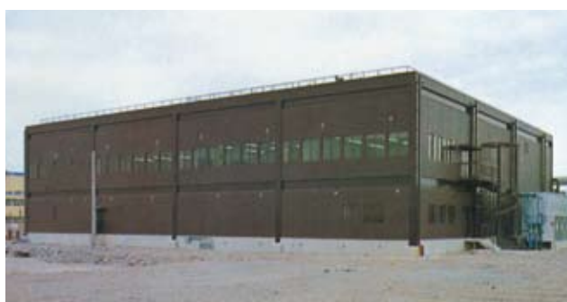
新日本製鉄広畑製鉄所東浜中央計算機室
