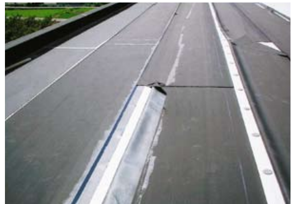
(シートの接合部の張付け)
